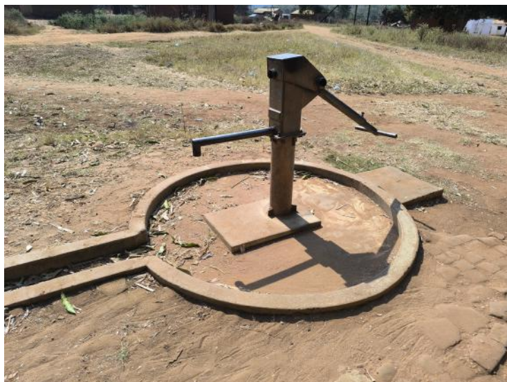
Figura 4-13: Fonte de água com Bomba inoperacional
