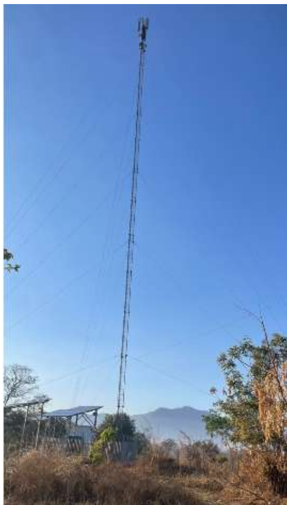
Figura 6-20: Antena da Movitel na área do Projecto
