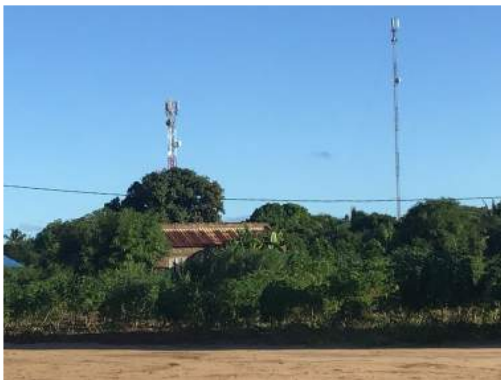
Figura 9-20: Antenas de Rede (Movitel e Vodacom)
